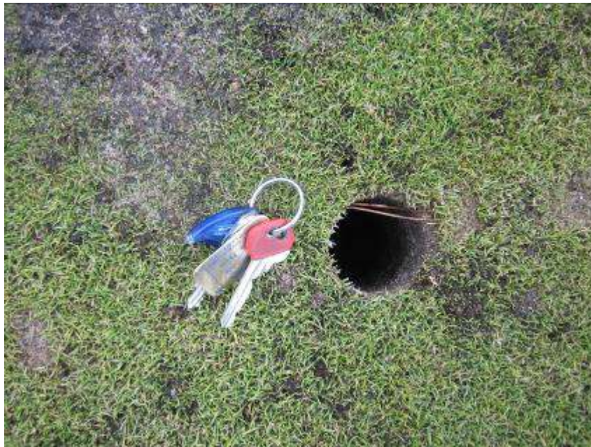
Bild 2. Exempel på hål i lågpunkt som står öppet hela vintern.
