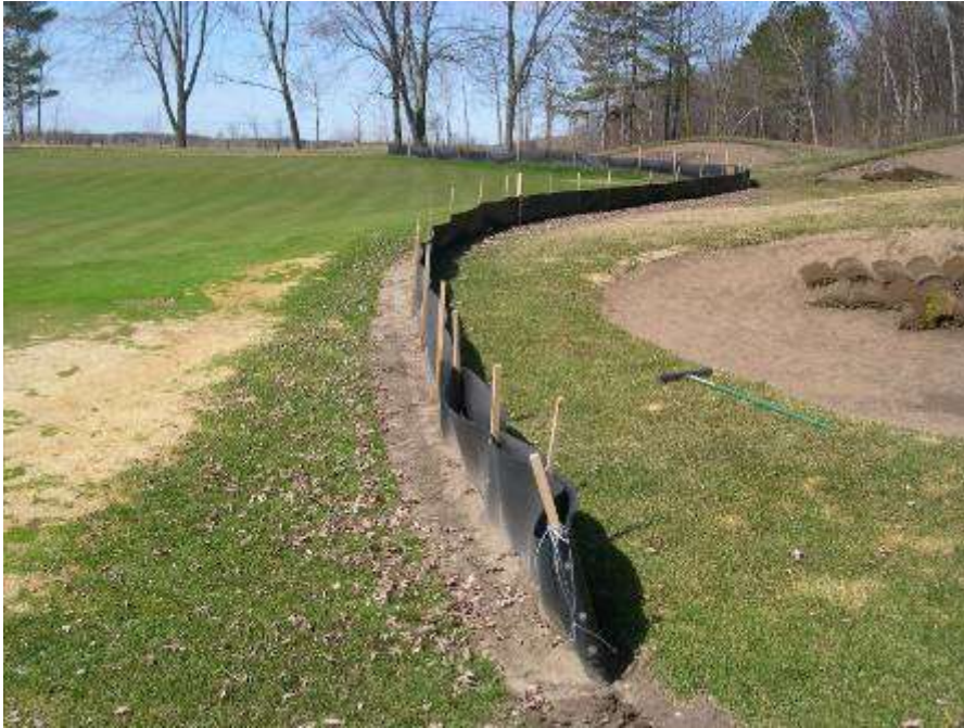
Bild 4. Exempel på "barriär" som hindrar smältvatten från att rinna in på green eller annan yta.
